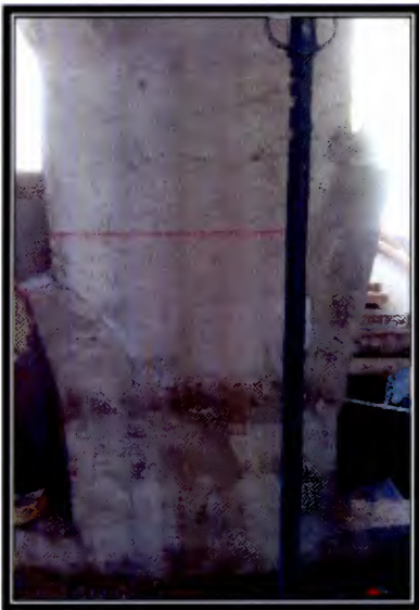
Foto 3, Foto 4 y Foto 5: Fallas en terminaciones del hormigón
