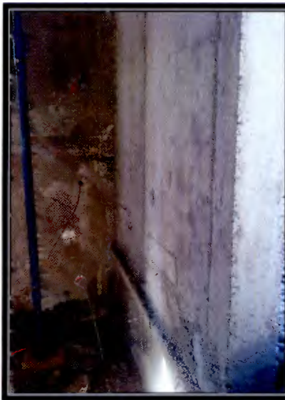
Foto 3, Foto 4 y Foto 5: Fallas en terminaciones del hormigón
