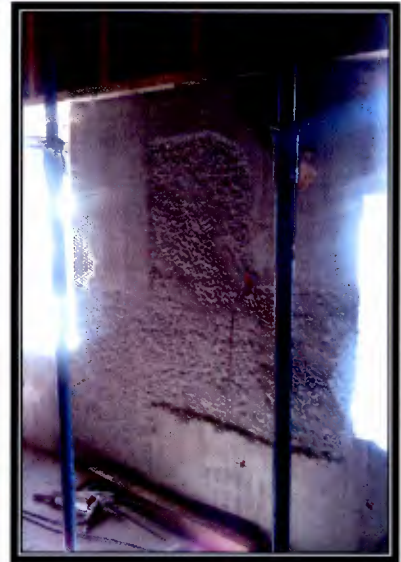
Foto 3, Foto 4 y Foto 5: Fallas en terminaciones del hormigón
