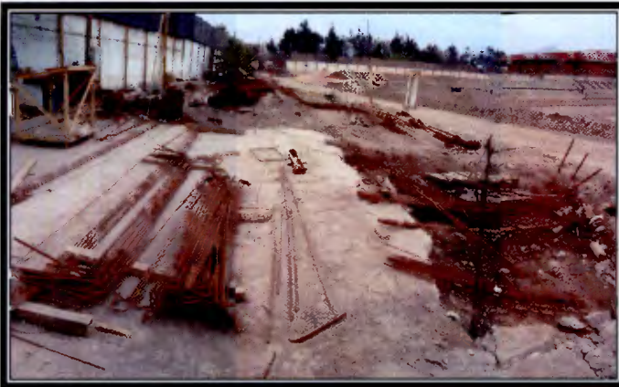
Foto 15 y Foto 16: Materiales acopiados en zonas abiertas y sin resguardo
