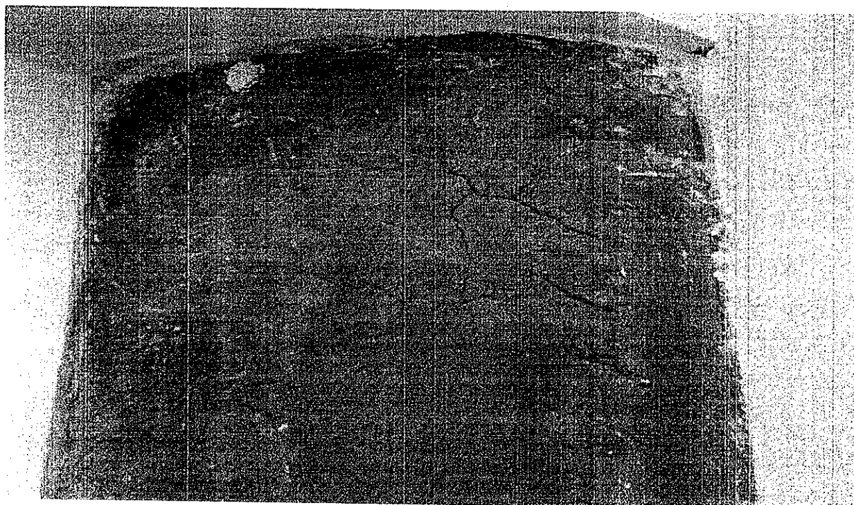
Fotografía N° 4: Fisuras en pilar de hormigón.
