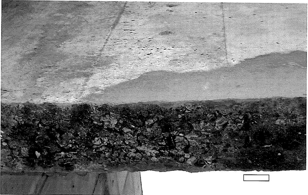
Foto N° 15: Enfierradura y segregación expuesta en el hormigón.
