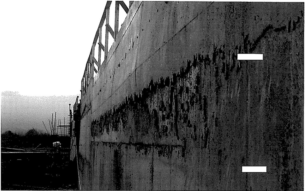
Foto N° 8: Rebarba de hormigón en elemento estructural.
