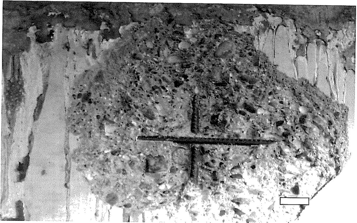
Foto N° 13: Enfierradura expuesta en el hormigón
