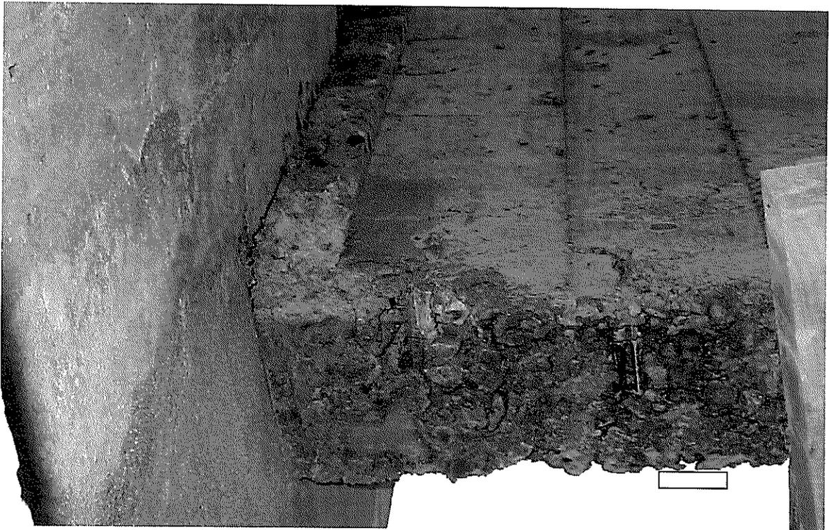
Foto N° 11: Enfierradura y segregación expuesta en el hormigón.
