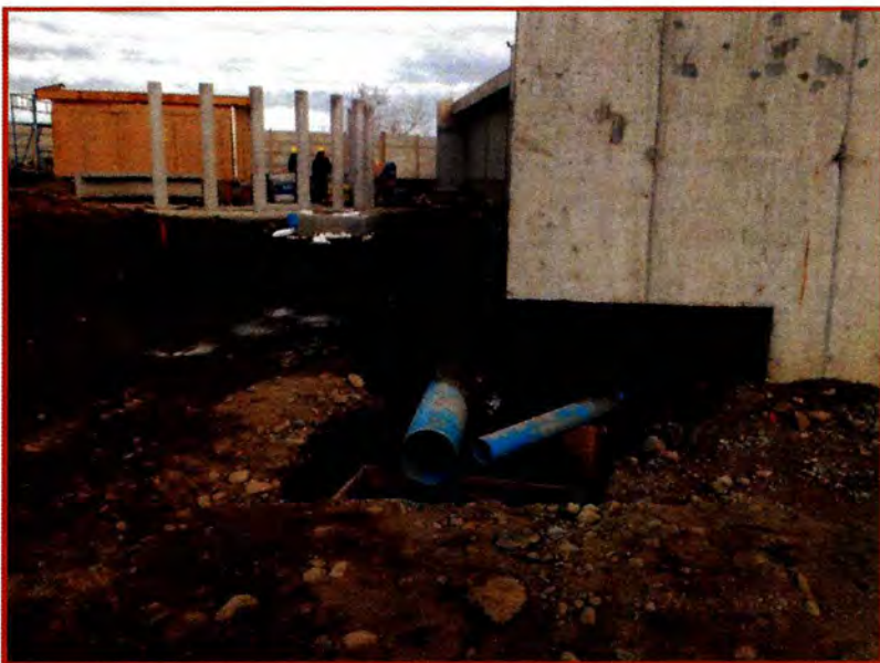
Fotografía N° 4. Ausencia de señalización de peligro de caída.
