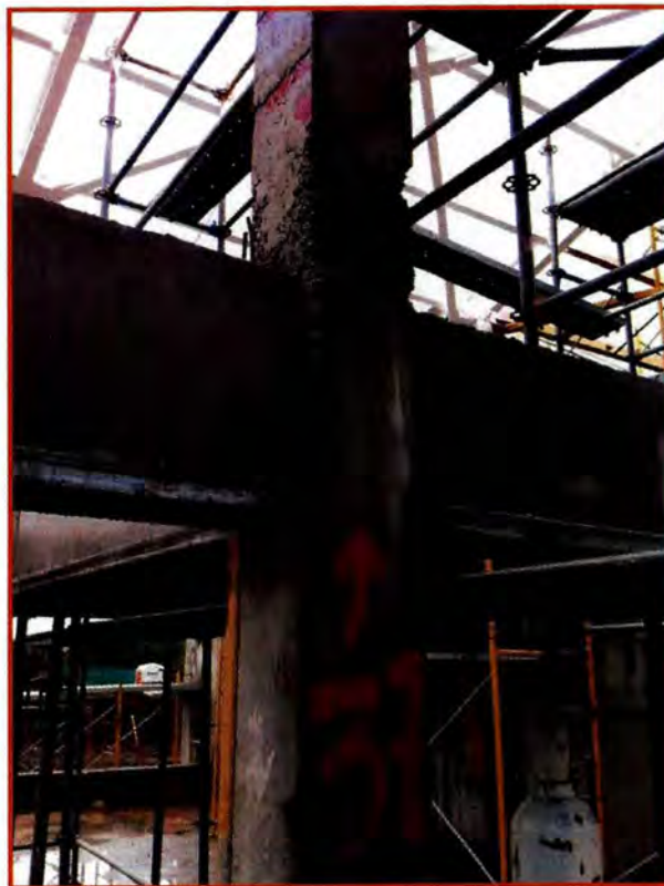
Fotografía N° 4, nido de piedras en pilar, intersección ejes I y 2, Módulo de Servicios (F).
