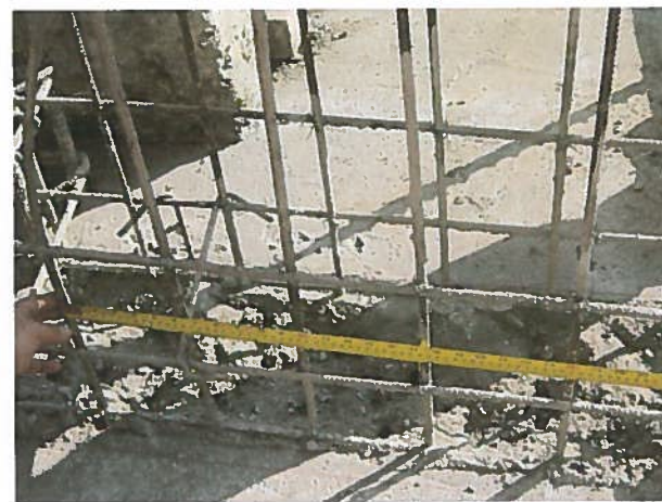
Fotografía N°20 Lugar: 4° Subt., en Eje A Detalle: Fierros verticales de 10 mm. a 15 cm. de acuerdo con plano de terreno. Fecha: 15.05.12
