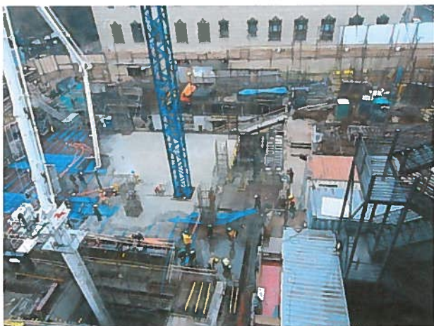
Fotografías N°9 y 10 Lugar: Eje 3ª—5a y D1—G1, Cielo 2° Zócalo. Detalle: Faena de hormigonado en período de lluvia. Fecha: 29.06.12
