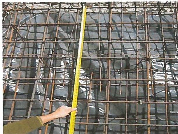
Fotografía N°18 Lugar: 4° Subt., en eje A, entre pilas 4 y 5. Detalle: Fierros horizontales de 12 mm. en muro de acuerdo con plano de terreno. Fecha: 15.05.12
