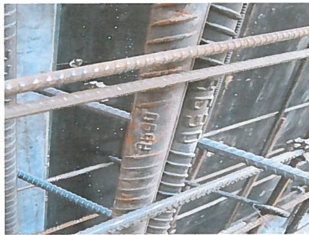
Fotografía :N°12 Lugar: 4° Subt., en eje 8-b Detalle: Corresponde a lo especificado, acero CAP calidad A 63—42. Fecha: 15.05.12
