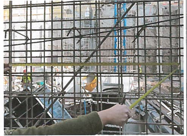
Fotografía N°24 Lugar: 4° Subt., muro en eje G2, entre Ejes 6-A y 7-C. Detalle: Fierros verticales de 10 mm. a 15 cm. de acuerdo con plano de terreno. Fecha: 15.05.12
