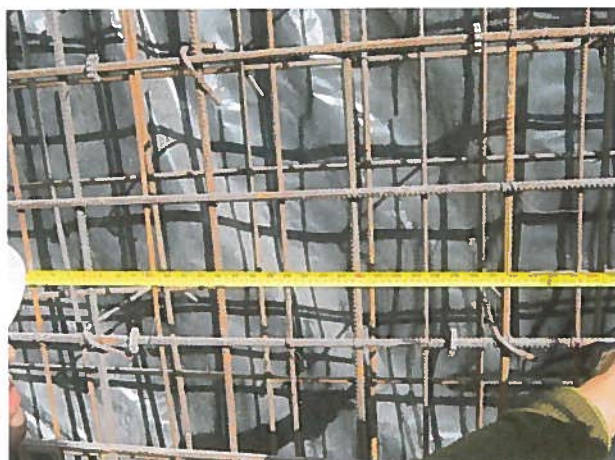
Fotografía N°17 Lugar: 4° Subt., de eje A, entre pilas 4 y 5. Detalle: Fierros verticales de 12 mm. a 20 cm. en muro de acuerdo con plano de terreno. Fecha: 15.05.12
