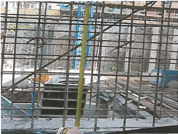
Fotografía N°23 Lugar: 4° Subt., en muro en eje G2, entre Ejes 6-A y 7-C. Detalle: Fierros horizontales de 10 mm. a 15 cm. de acuerdo con plano de terreno. Fecha: 15.05.12
