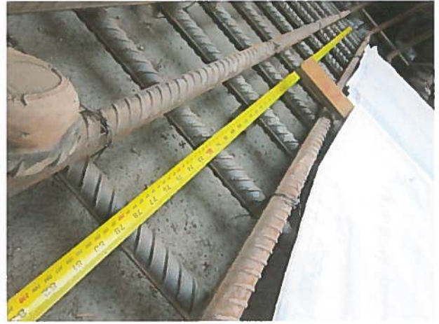
Fotografía N°28 Lugar: 4° Subt., en fundación de cruce de Eje 8-A con Eje C. Detalle: Fierros de 32 mm. a 18 cm., en dirección norte – sur, de acuerdo con plano de terreno. Fecha: 15.05.12
