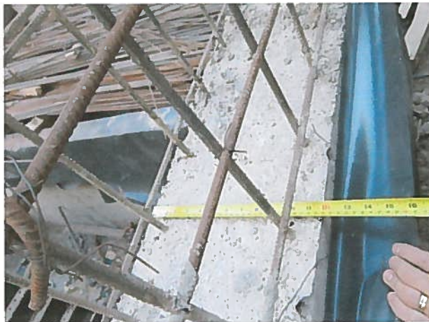
Fotografía N°25 Lugar: 4° Subt., muro de Eje G2, entre Ejes 6-A y 7-C. Detalle: Espesor 30 cm de acuerdo con plano de terreno. Fecha: 15.05.12
