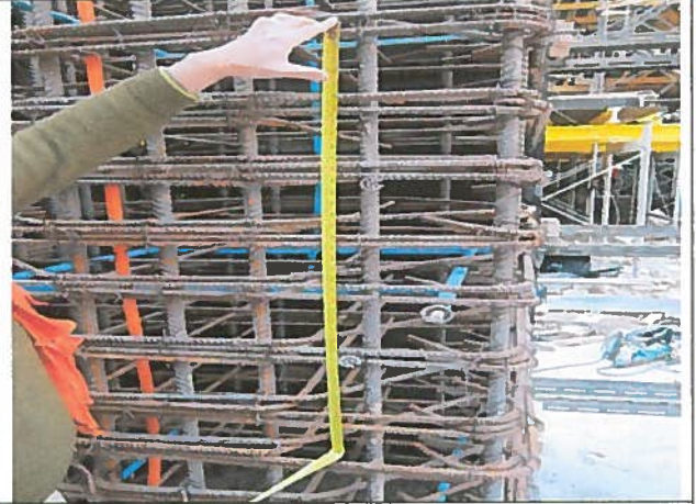
Fotografía N°22 Lugar: 4° Subt., Pilar cruce Eje E-1 y 3-A Detalle: 7 fierros de 16 mm. a 15 cm., de acuerdo con el plano de terreno. Fecha: 15.05.12
