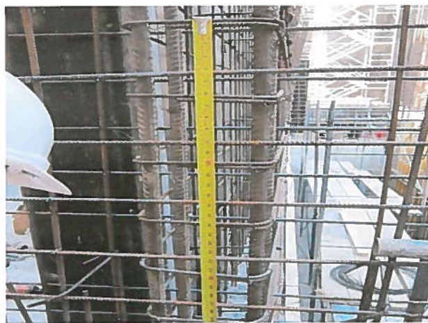
Fotografía N°13 Lugar: 4° Subt., muro en eje 8—b. Detalle: Fierro estribos de 8 mm. @ 15 cm. conforme a planos de estructuras de terreno. Fecha: 15.05.12
