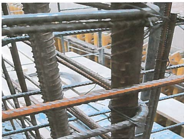
Fotografía N°11 Lugar: 4° Subt., en eje 8 – b. Detalle: Fierro de diámetro 22 mm. corresponde a lo señalado en plano EST – 36. Fecha: 15.05.12
