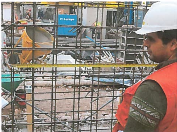
Fotografía N°15 Lugar: 4° Subt., en eje 8 – b. Detalle: Fierro en malla de 8 mm. @ 15 cm. vertical de acuerdo con plano de terreno. Fecha: 15.05.12
