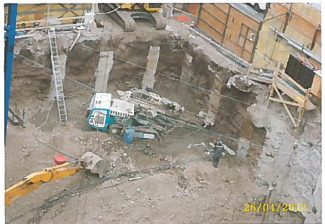
Fotografía N°2: Rampa parcialmente excavada y actividades de terminación de trabajos de anclaje de las pilas 15 a 24. Fecha: 26.04.2012.
