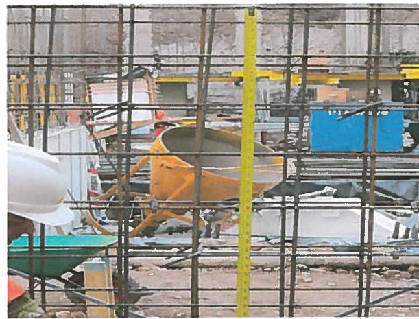
Fotografía N°14 Lugar: 4° Subt., muro en eje 8—b Detalle: Fierro en malla de 8 mm. @ 15 cm. horizontal de acuerdo con plano de terreno. Fecha: 15.05.12
