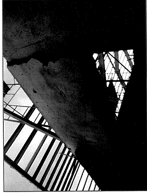
Fotografía N° 21, nido de piedras en muro pasillo, sector pre básica
