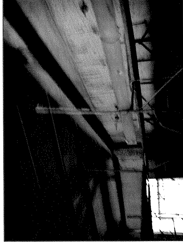
Fotografía N° 25, material aislante expuesto
