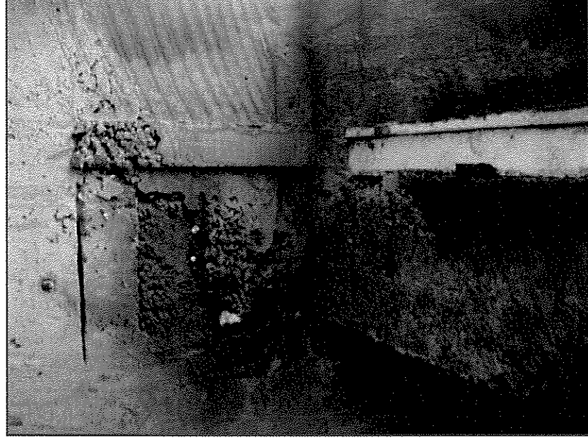
Fotografía N° 19, nido de piedras en dintel acceso a sector A. (Intersección del eje S y los ejes 6 y 7)
