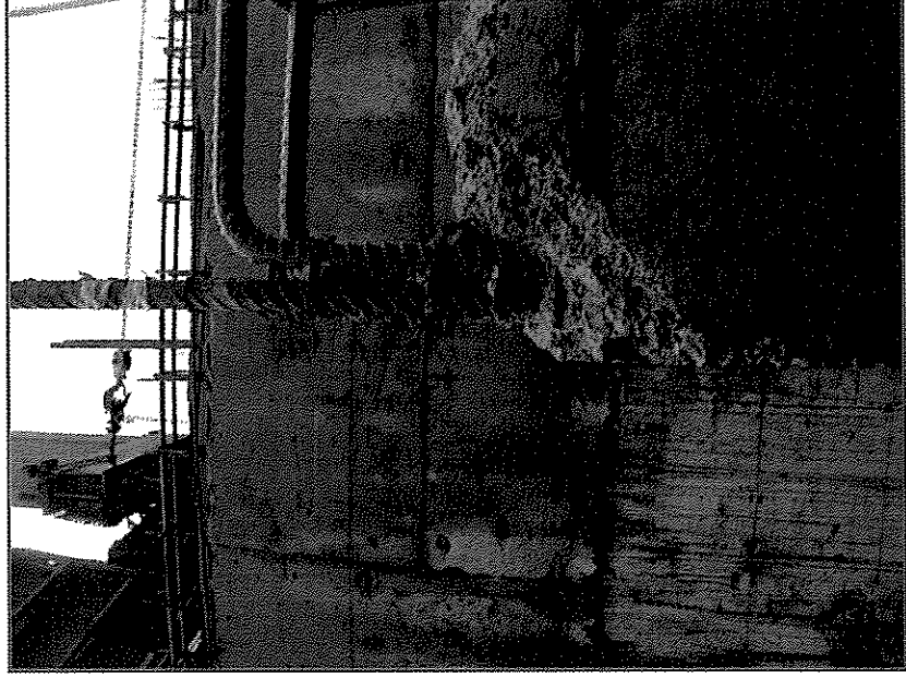
Fotografía N° 4, recubrimiento deficiente. (Gimnasio)
