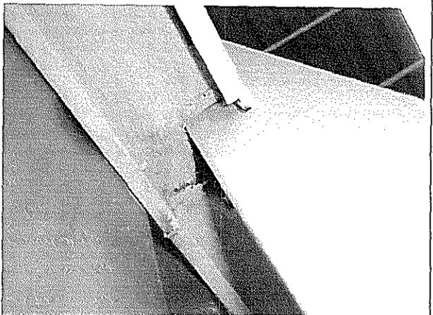
Fotografía N°20: Falta de cubrimiento de pintura bajo vigas metálicas.
