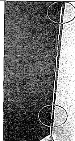
Fotografía N°15: Dos de tres bisagras instaladas en puerta metálica en oficina existente remodelada.
