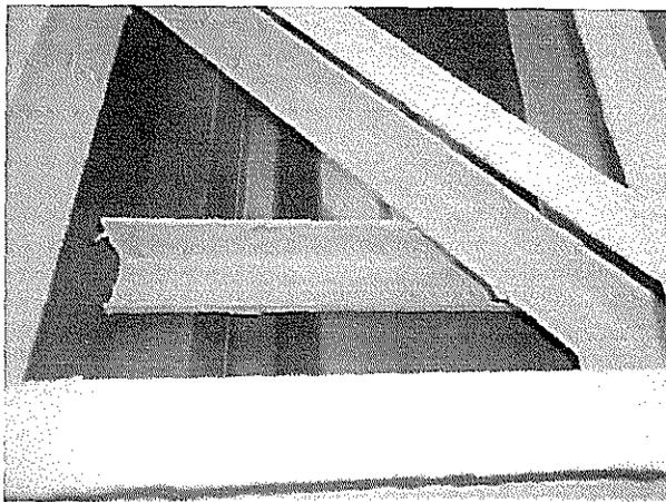
Fotografía N°19: Galpón N°2: Falta de cubrimiento de pintura bajo vigas metálicas.
