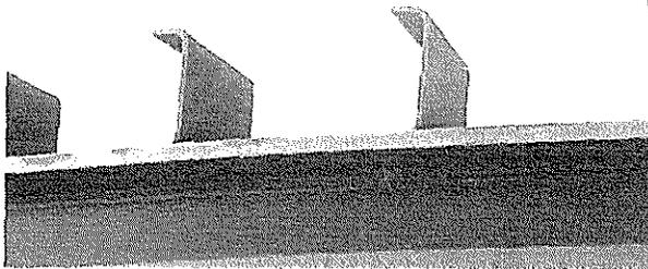
Fotografía N°9: Viga longitudinal instalada con presencia de oxido.
