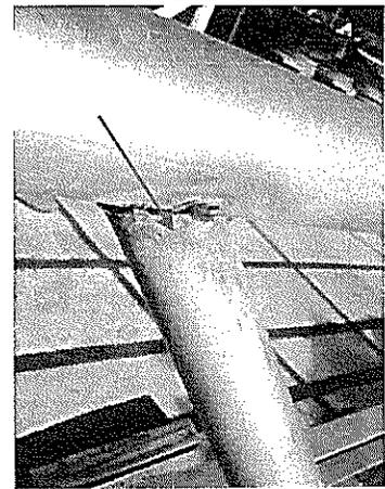
Fotografía N<sup>o</sup>15: Falta de pernos de sujeción de pletina galvanizada en muro rompeolas.
