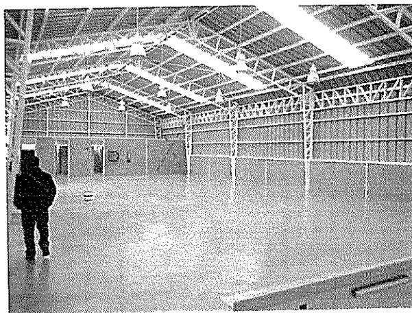
Fotografía N°14: Vistas ejes A y B de galpón N°1 sin sistema de arriostamiento en sus extremos.
