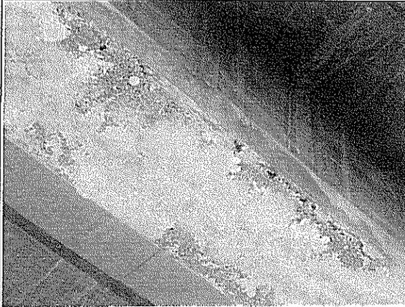
Fotografía N°4: Nidos de piedra en viga central entre estribo E-1 y cepa.
