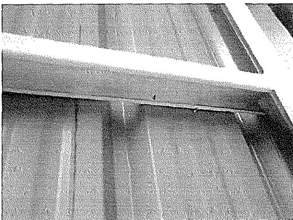
Fotografía N°21: Falta de cubrimiento de pintura bajo vigas metálicas.
