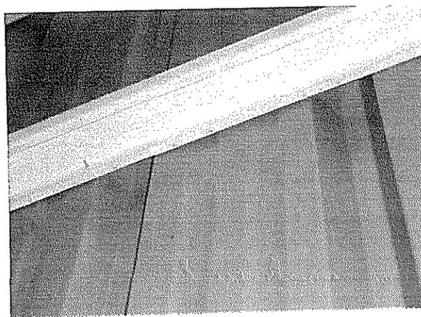
Fotografía N°16: Galpón N°1: Falta de cubrimiento de pintura bajo vigas metálicas.
