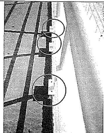
Fotografías N<sup>os</sup> 13 y 14: Falta de sujeción a muro de coronamiento de hormigón de pletina galvanizada de baranda metálica.
