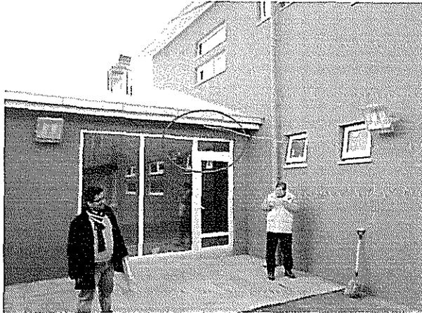
Fotografía N°9: Falta instalación de foco proyector perimetral sobre acceso a sala multiuso.
