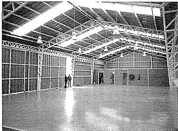
Fotografía N°13: Vistas ejes A y B de galpón N°1 sin sistema de arriostamiento en sus extremos.
