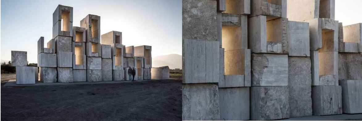
"Muro de Luz" de José Vicente Gajardo en la Ruta 5 Tramo Vallenar – Caldera.
