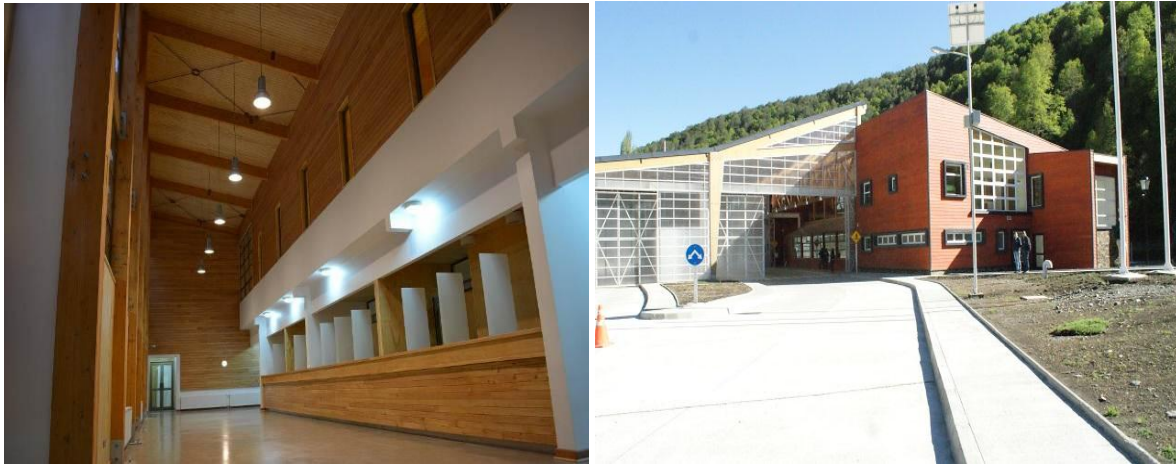
Imágenes Obra Terminada Instalaciones Paso Fronterizo Hua-Hum
