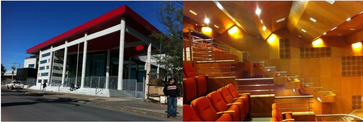
Obra destacada y terminada durante el año 2013: Teatro Regional de O'Higgins.
